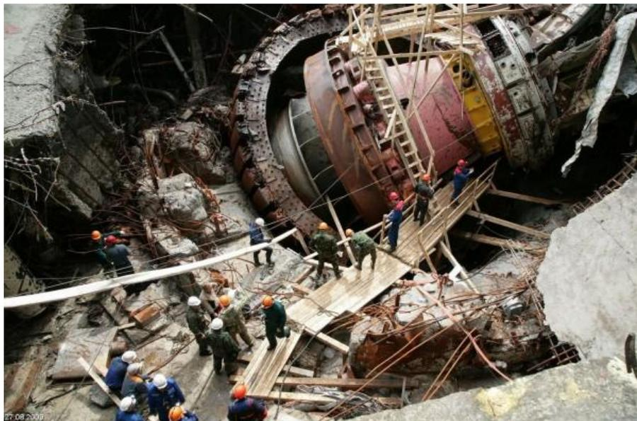
**Причина аварии:** разрушение шпилек крепления крышки турбины гидроагрегата, вызванное дополнительными динамическими нагрузками переменного характера, что привело к срыву крышки и затоплению машинного зала станции.
