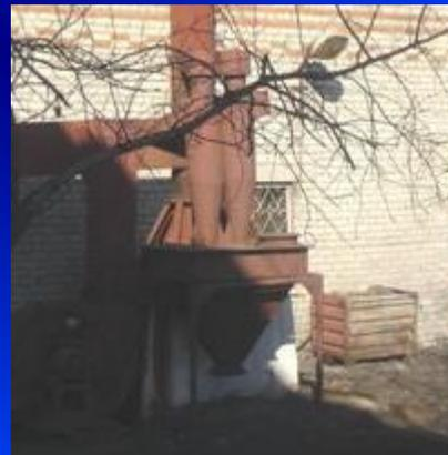
Фильтрующая установка циклон
