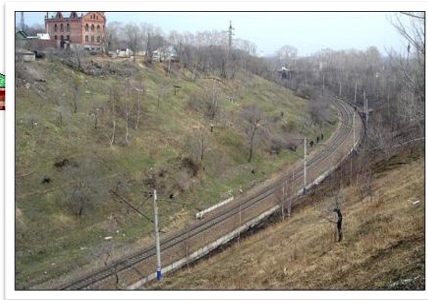
Выемка: 1-полоса отвода; 2-нагорная канава; 3-кавалер; 4-забанкетная канава; 5-банкет; 6-кювет; 7-балластный слой; 8-обочина.
