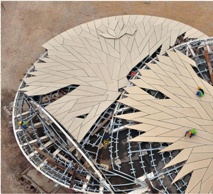
Грандиозное сооружение выглядит действительно очень эффектно благодаря невероятному внешнему виду. Его конструкция состоит из 250 тысяч различных элементов созданных из армированного стекловолокном бетона, и каким-то необъяснимым образом, прикрепленным к стальной раме, а также из 539 огромных пересекающихся дисков, которые создают уникальной формы крышу.
