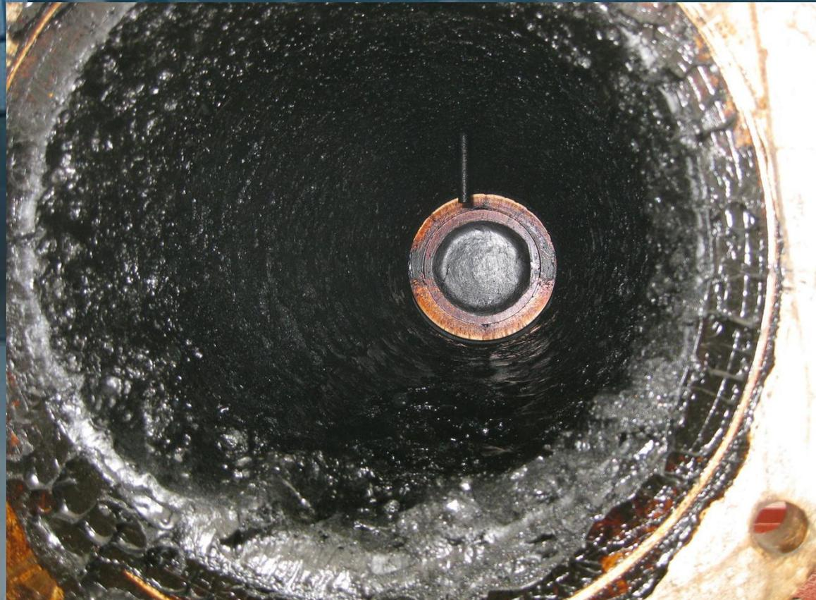
*М100 при температуре 5°C образует слой толщиной  $\delta=5$  мм. Для полного удаления такого слоя нужно подогреть мазут до температуры 70°C.*
