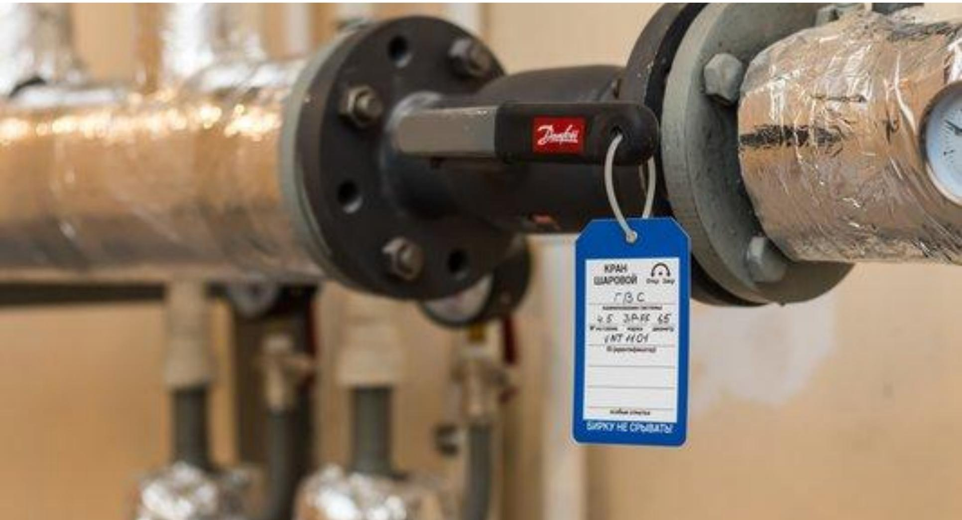
**Регулирующие клапаны оборудуются указателями степени открытия регулирующего органа, а запорная арматура - указателями "открыто" и "закрыто". Арматура должна быть доступна для обслуживания**
