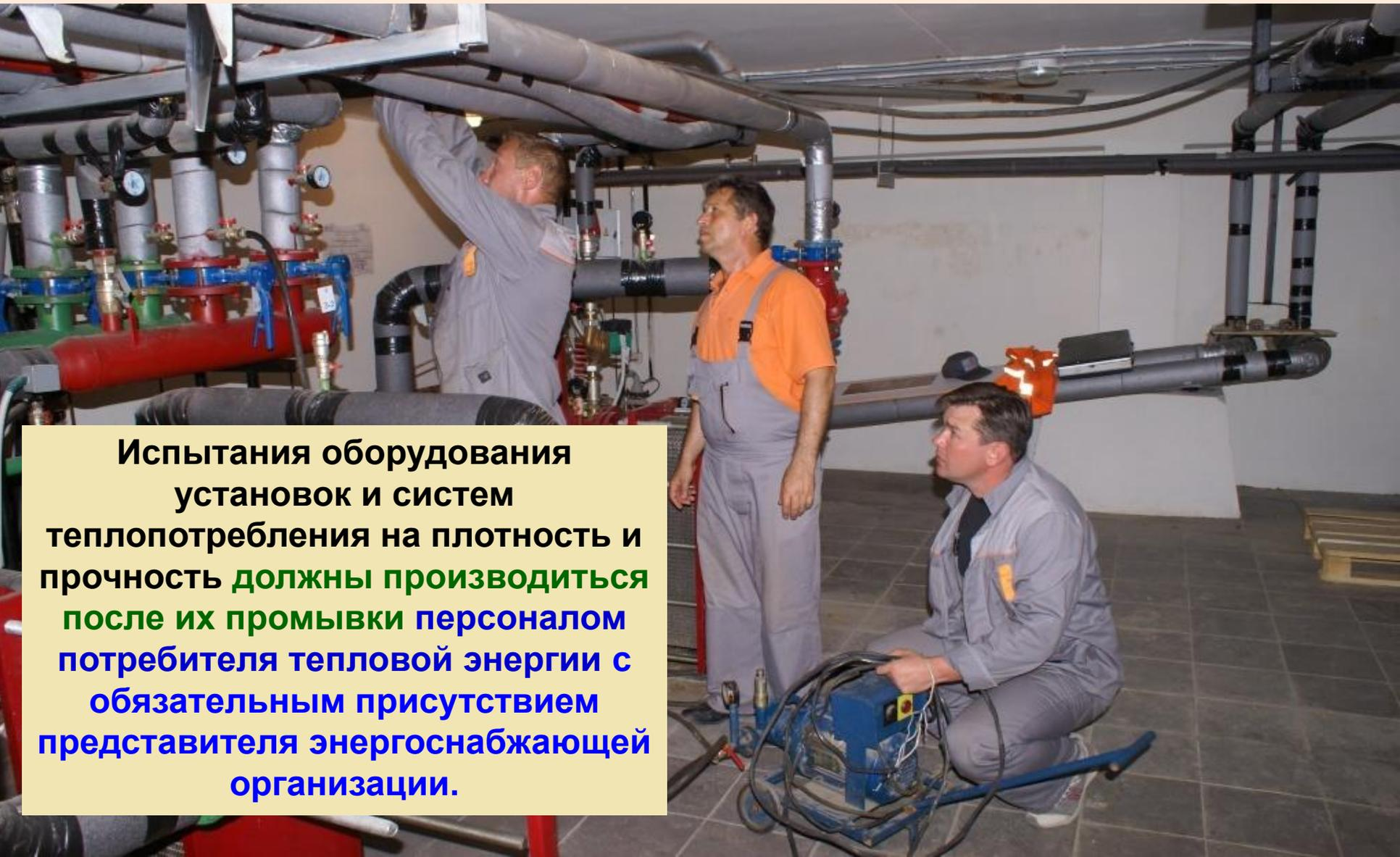
**Испытания оборудования установок и систем теплоснабжения на плотность и прочность должны производиться после их промывки персоналом потребителя тепловой энергии с обязательным присутствием представителя энергоснабжающей организации.**
