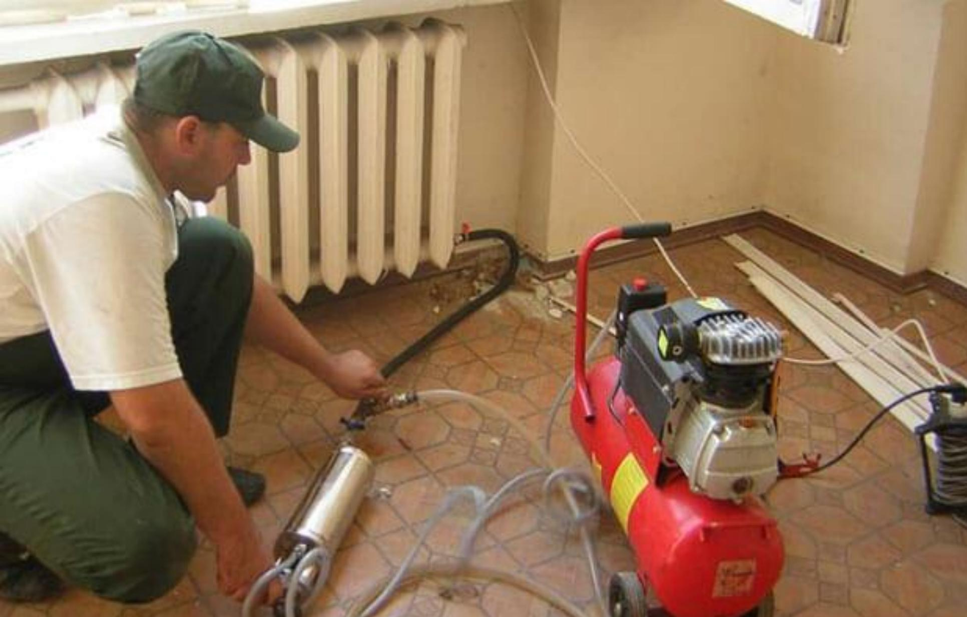
**При проведении гидропневматической промывки расход водо-воздушной смеси не должен превышать 3 - 5-кратного расчетного расхода теплоносителя**
