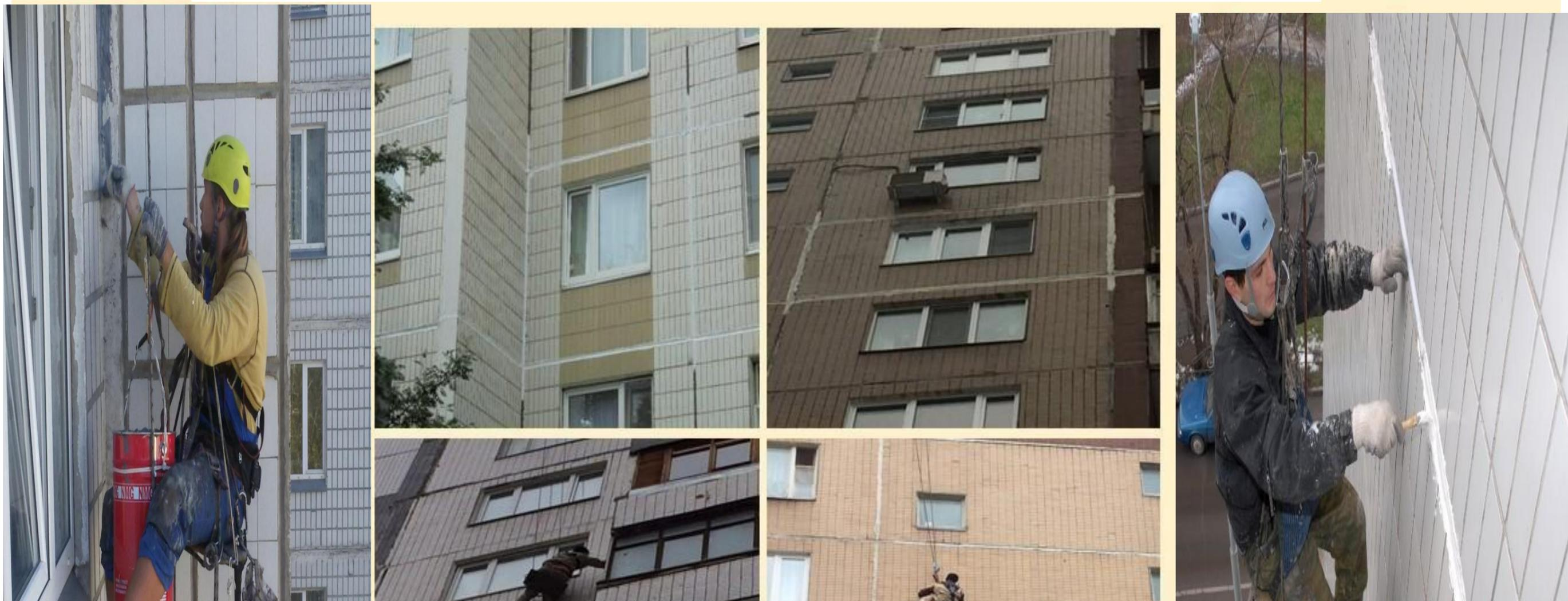
В прошлом году восстановлена герметичность МПШ общей протяженностью почти 2,7 тыс. пог. м более 50 квартир и мест общедомового имущества. Кроме того, восстановлена гидроизоляция балконов в более 15 квартирах
