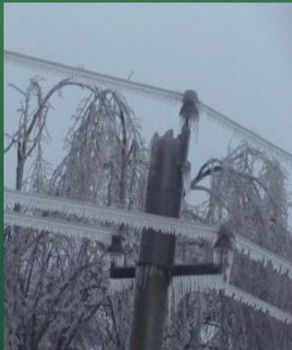
Зимой 2001 года в Сочи сложилась чрезвычайная ситуация в связи с энергообеспечением. Обледенение проводов привело к повреждению 2,5 тысяч км воздушных линий электропередач напряжением до 220 кВ, в результате чего большинство районов города остались без света, тепла и воды. Работы по восстановлению ЛЭП осложнялись плохими погодными условиями и тем, что обрывы произошли в труднодоступных горных районах.
