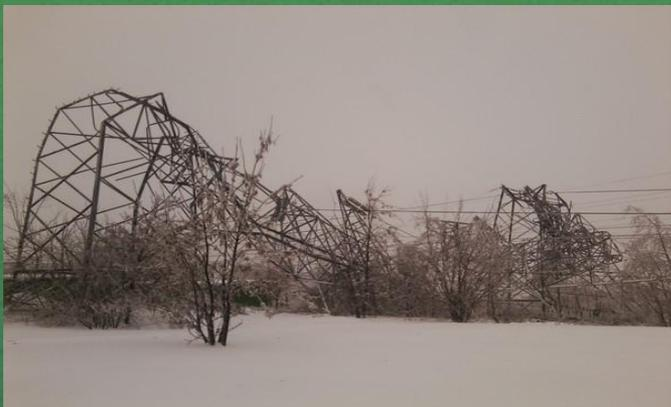
В декабре 2010 года в Москве на участке в 1,5 км произошло обрушение пяти опор линий электропередач. Из-за сильного обледенения металл не выдержал и опоры наклонились.
