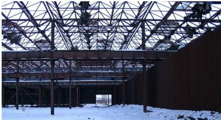
**Каркас здания со структурным блоком «Москва»**
