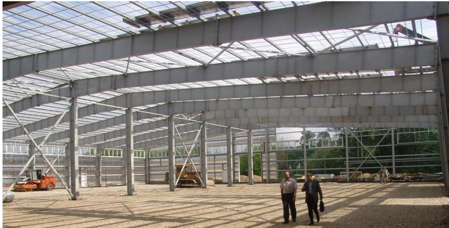
**Каркас здания с двухпролетными рамами из сварных двутавров**
