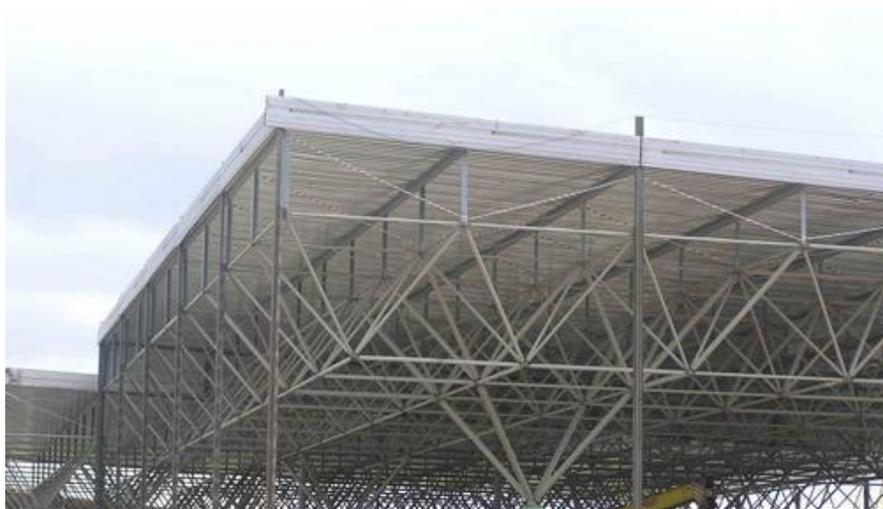
**Каркас здания со структурной плитой**
