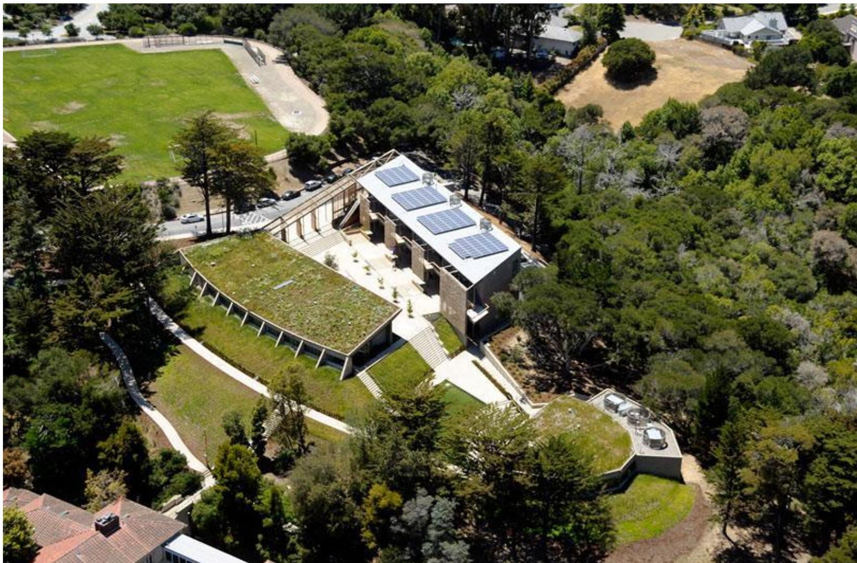
Сады несут не только эстетические, но и иные функции: являются теплоизоляцией, участвуют в процессе очистки сточных вод, включены в систему вентиляции помещений.
