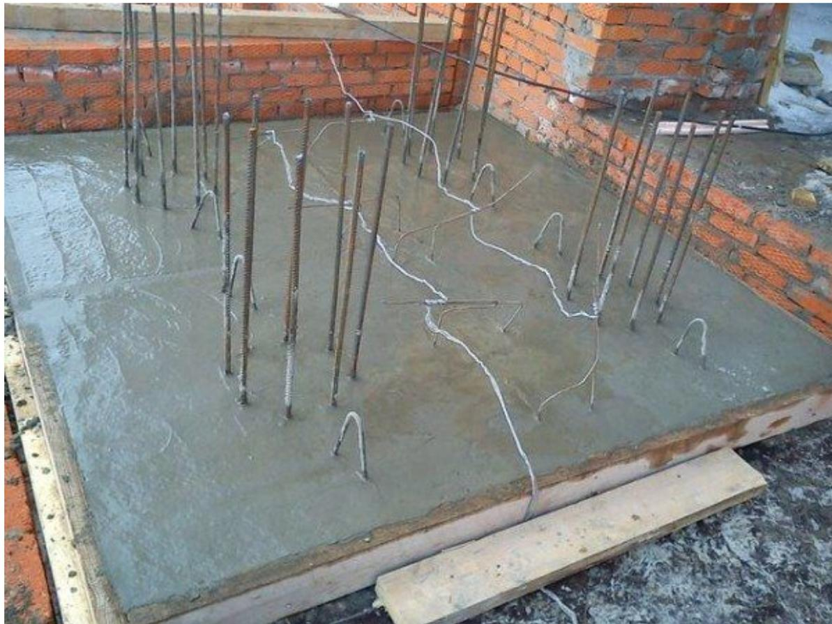
Установку и подключение электродов предпочтительно осуществить **до** начала бетонирования
