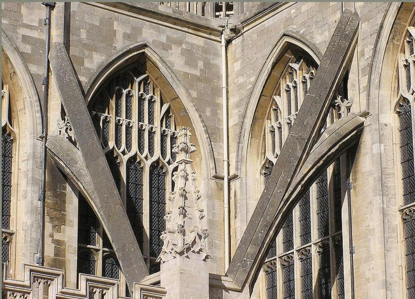
Два аркбутана передают нагрузку на один контрфорс
