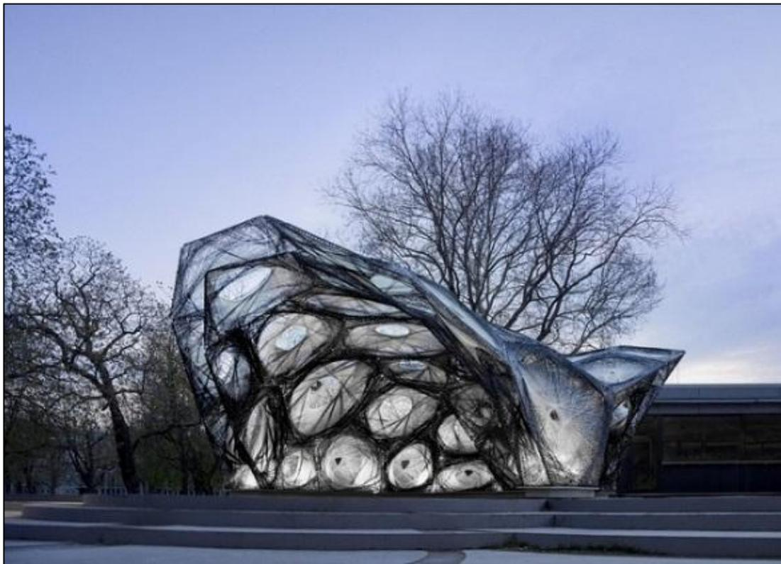
Архитекторы и конструктора из университета Штутгарта собрали необычный парковый павильон с жестким ортогональным каркасом, оплетенным карбоновым волокном. Вдохновляющим фактором для команды послужила структура крыльев жука, на основании которой была создана 3д-модель сооружения.
