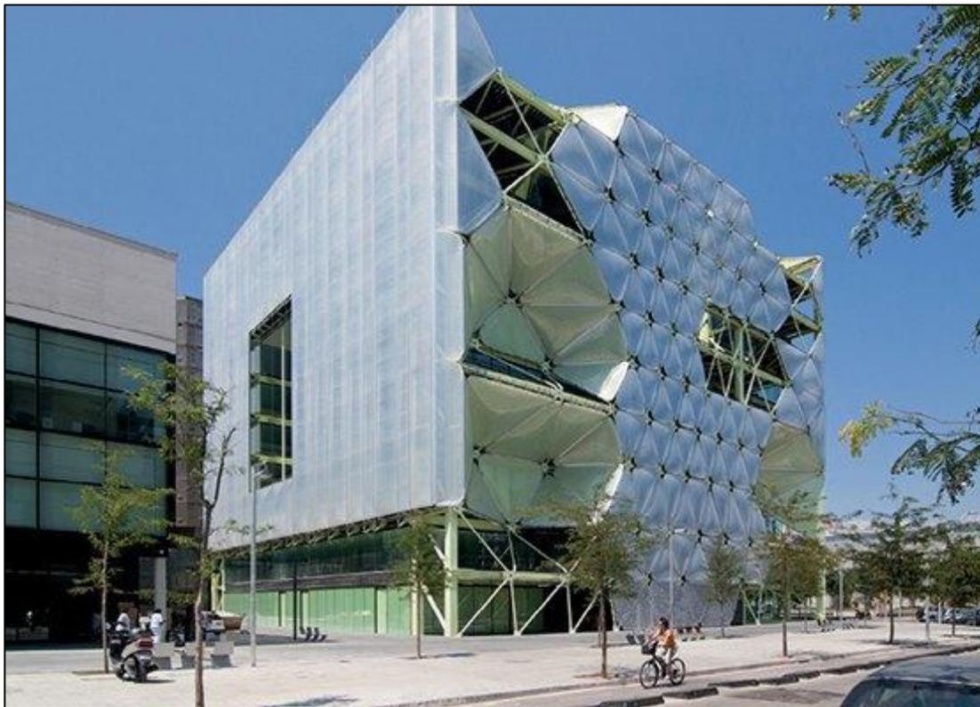
спроектированное студией архитектора Энрика Руис Гели с надувным фасадом. В воздушные камеры треугольной формы вмонтированы датчики освещённости, которые расширяют, либо сжимают камеры, в зависимости от интенсивности солнечного излучения, тем самым регулируя микроклимат и свет внутри помещения.
