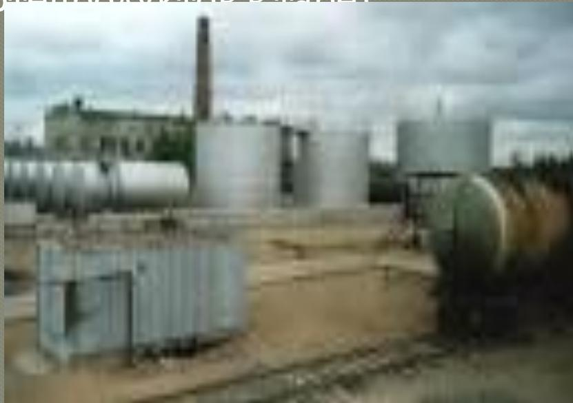
**3. Хранения нефтепродуктов – где размещаются резервуарные парки, резервуары малой вместимости (мерники), обвалование – огнестойкие ограждения вокруг резервуарных парков.**
