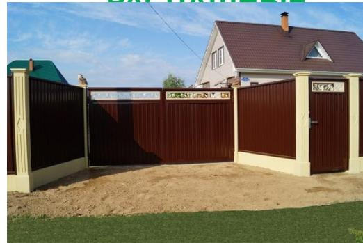
**Распашные ворота** – это классика, проверенная временем. На сегодняшний день такой тип ворот является наиболее востребованным. Конструкция очень проста и не имеет сложных элементов, за счет этого она обладает невысокой стоимостью и отличными эксплуатационными характеристиками. Ворота комплектуются петлями и запорным комплектом LOCINOX, ведущего европейского производителя уличной фурнитуры. По желанию на ворота может быть установлена автоматика CAME или NICE.
