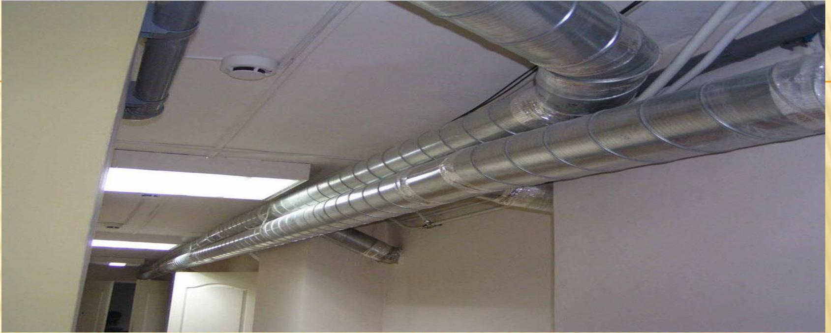
**Центральная искусственная вентиляция — это комплекс специальных сооружений и технических устройств, обеспечивающих воздухом все крытое спортивное сооружение. Она может быть приточной, вытяжной или приточно-вытяжной.**
