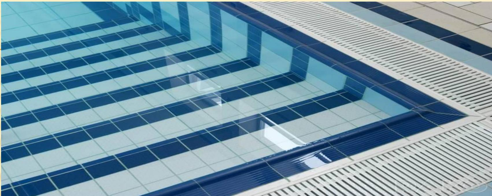
С внутренней стороны ванна бассейна облицовывается кафельной плиткой. Вдоль стен на уровне поверхности воды оборудуются специальные желоба для слива в канализацию поверхностного загрязненного слоя воды.
