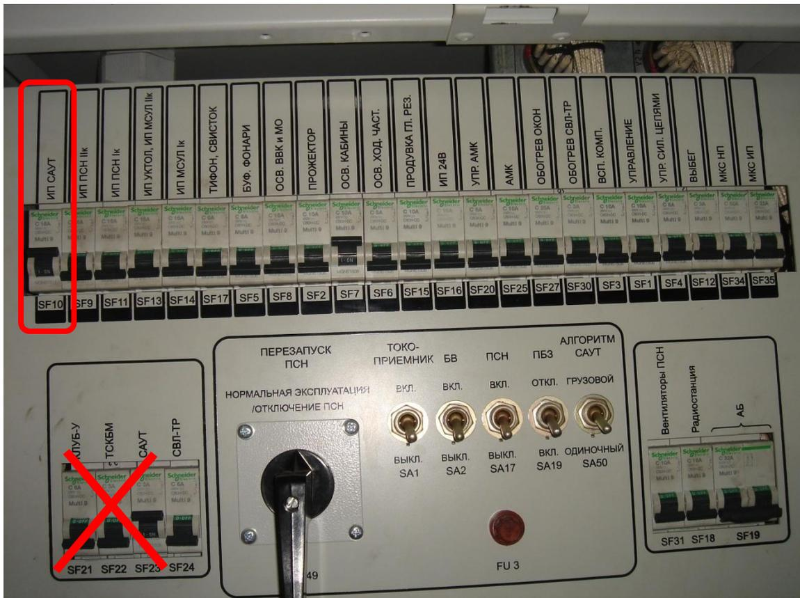
Система БЛОК включается автоматом SF10 «БЛОК» (на 2ЭС10 - SF14) «ИП САУТ» (SF 10) панели автоматов шкафа МПСУиД. При смене кабин автомат SF14 следует выключить. (Автоматы SF21, SF22, SF23 на 2ЭС6-046 в схеме БЛОК не задействованы.)
