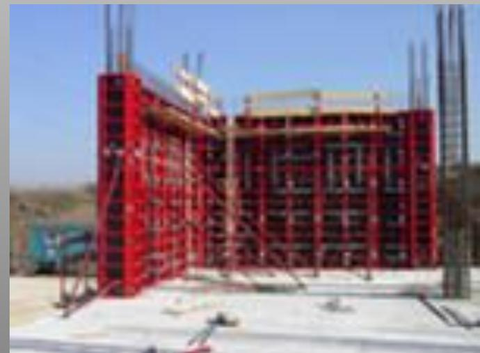
**Опалубка** — (от палуба, опалубить - покрыть настилом из досок и т.п.), совокупность элементов и деталей, предназначенных для придания требуемой формы монолитным бетонным или железобетонным конструкциям.
