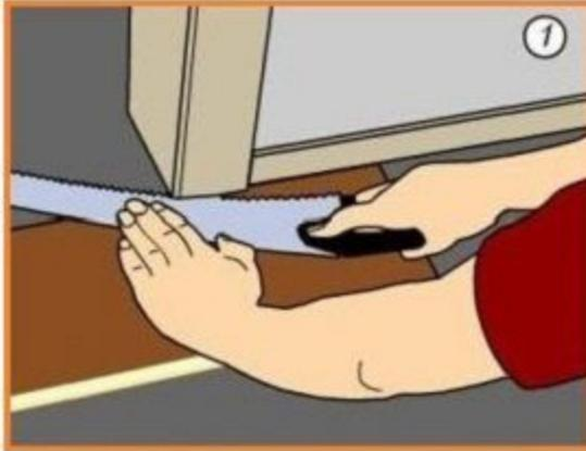
1 - Подпиливаем дверные косяки на толщину напольного покрытия
