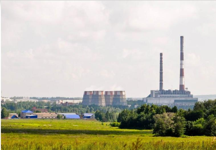
Ижевская ТЭЦ-2 введена в эксплуатацию **3 декабря 1975 года**. Установленная электрическая мощность станции **390 МВт**, тепловая – **1474 Гкал/ч** (в том числе 5 водогрейных котлов ПТВМ-180 ст. № 1,2 и КВГМ-180 ст. № 3,4,5 – 900 Гкал/ч).
