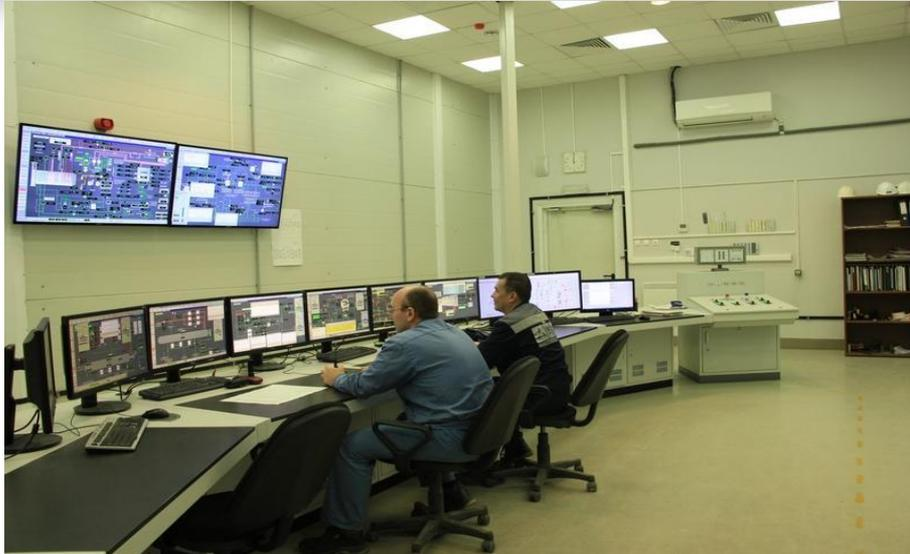
2 июня 2014 года на Ижевской ТЭЦ-1 состоялся торжественный пуск нового энергоблока – парогазовой установки мощностью 230 МВт. В результате реконструкции ТЭЦ-1 увеличилась ее установленная электрическая мощность с 60 МВт до 290 МВт. Установленная тепловая мощность выросла на 140 Гкал/ч и составила 643,8 Гкал/ч. КПД блока ПГУ превысил 50 %, что примерно в 1,5 раза выше КПД обычного паротурбинного оборудования, которым оснащено большинство отечественных электростанций.
