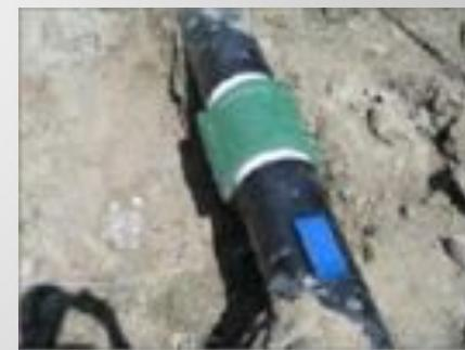
Муфта смонтирована. Магнитный маркер установлен
