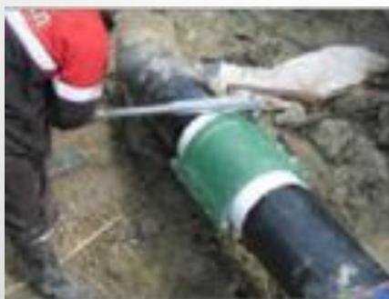
Тарированная протяжка болтов по схеме
