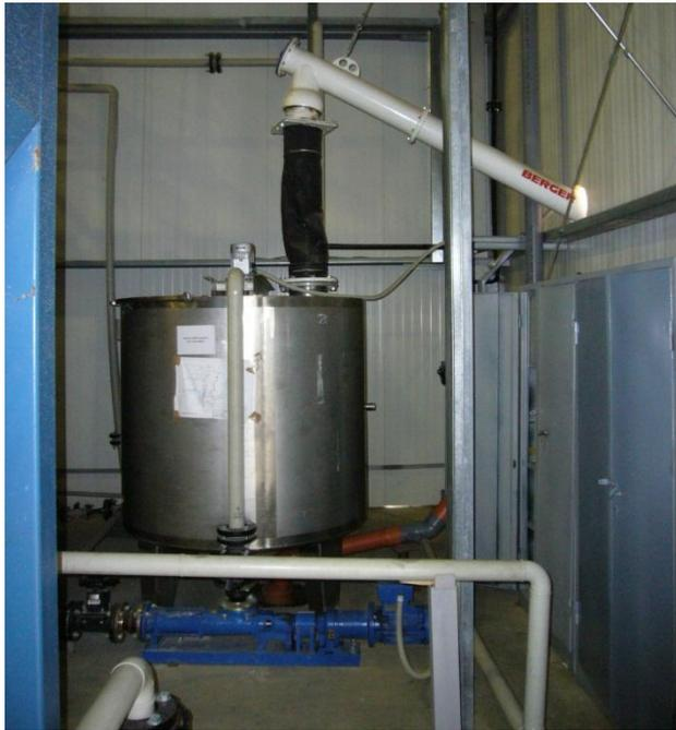
» Твердая фракция перекачивается в сборник шлама, а жидкая фракция вводится в установку агломерации / нейтрализации.
