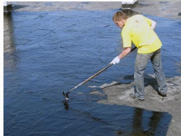
Устройство крыши с мастичным гидроизоляционным ковром
