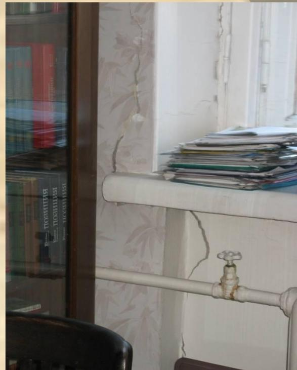
При обследовании наружных несущих стен здания были обнаружены трещины. Трещины развиваются как в вертикальном направлении, так и по наклонной. Большинство трещин располагается под оконными проемами или вокруг них.
