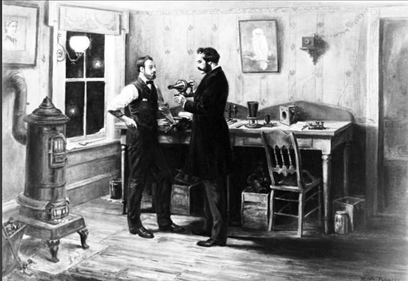
Трудясь над «музыкальным телеграфом», Белл и Ватсон работали в разных комнатах, где были установлены передающий и принимающий аппараты. Камертонами служили стальные пластинки разной длины, жестко закрепленные одним концом, а другим замыкавшие электрическую цепь.
