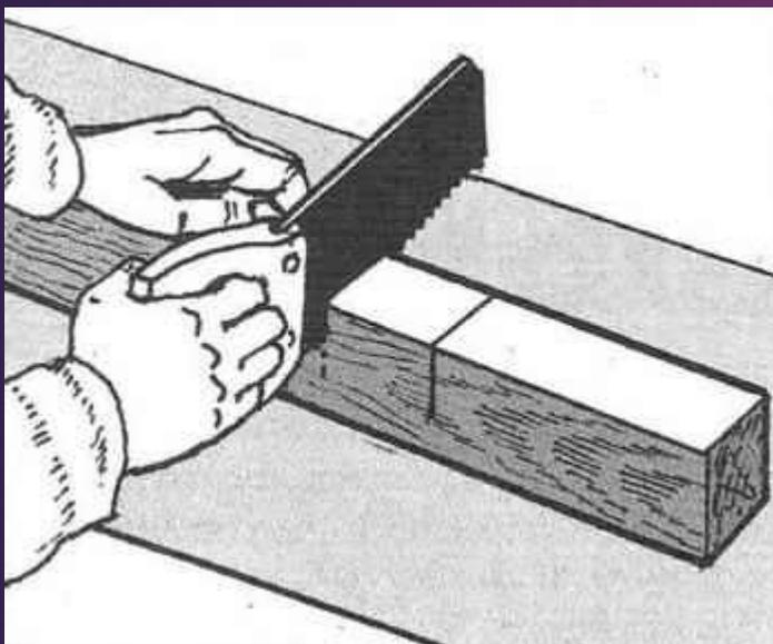
Заготовка деталей и выпиливание конструкции. Вот мы знаем материал и размеры скворечника – осталось всего лишь сконструировать его. Для начала стоит продумать схему скворечника и начертить ее. Рисунок должен содержать такие детали: днище, переднюю и заднюю стенку, боковые панели, крышку. По желанию можно сделать жердочку.
