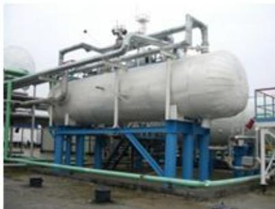
**Сосуд** - герметически закрытая емкость, предназначенная для ведения химических, тепловых и других технологических процессов, а также для хранения и транспортировки газообразных, жидких и других веществ. Границей сосуда являются входные и выходные штуцера
