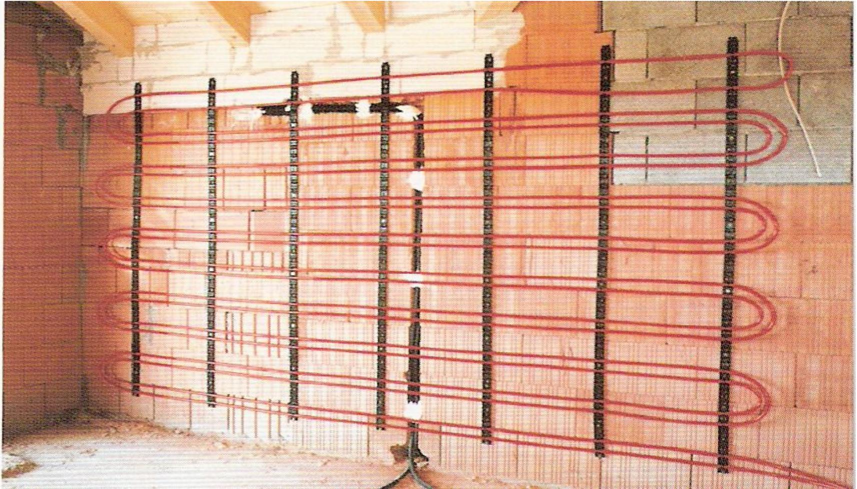
Греющая конструкция стены со встроенными нагревательными элементами, подготовленная под отделку.
