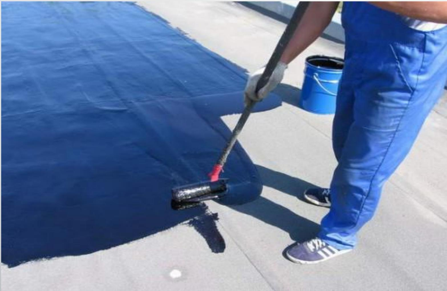
Основа под наливной кровельный материал должна быть выполнена из бетонных или деревянных перекрытий, цементной стяжки, металла, слоя утеплителя.
