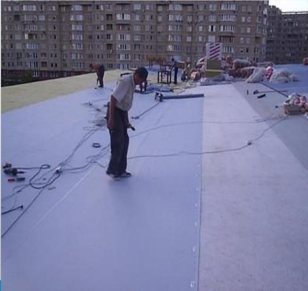
Мембраны и жидкие мастики могут выступать как самостоятельные финишные кровельные покрытия, так и находиться внутри кровельного пирога, например, в составе инверсионной кровли.
