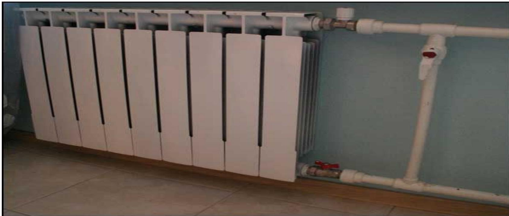
2 варианта подачи горячей воды в стояки системы отопления : с нижним розливом( в 5-ти-этажных домах – **завоздушивание** после слива воды летом) и верхним (в 9-этажном)
