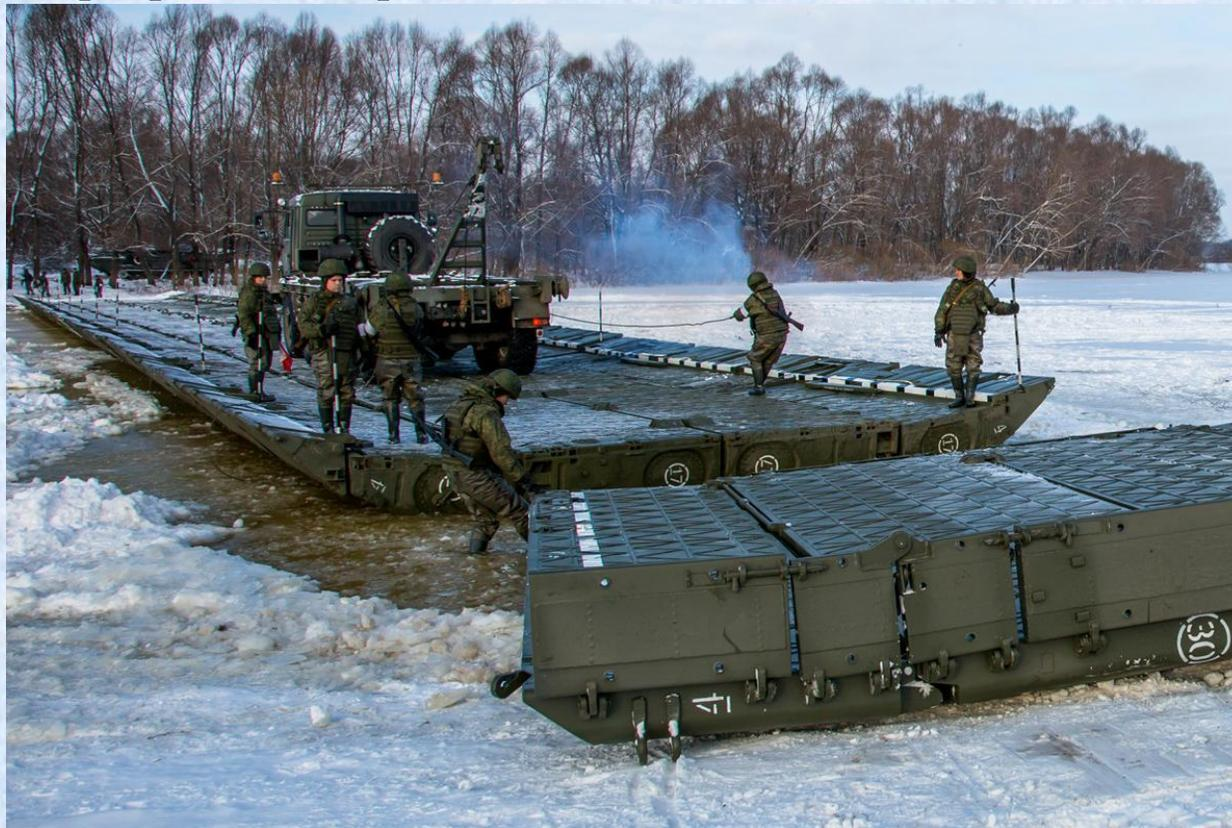
**Десантные переправы** предназначены для переправы на противоположный берег мотострелковых подразделений со средствами усиления (главным образом для переправы первого эшелона наступающих войск). Десантные переправы оборудуются для быстрого и рассредоточенного преодоления водной преграды. Подготовка такой переправы составляет "Ч" + 10–15 мин
