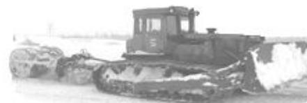
Перевозка очищенных почв и грунтов на рекультивируемый участок, планировка бульдозером
