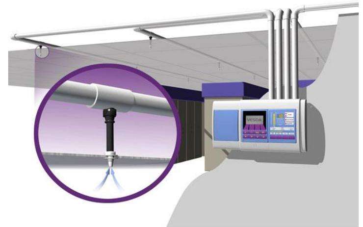
Рис. 15 – Система проточного дымового извещателя VESDA
