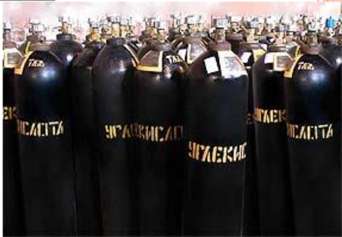
1. Баллоны с CO<sub>2</sub> - хранятся на газобаллонной станции, размещенной в отдельном помещении с наружным выходом, расположенном вблизи сатураторов.
