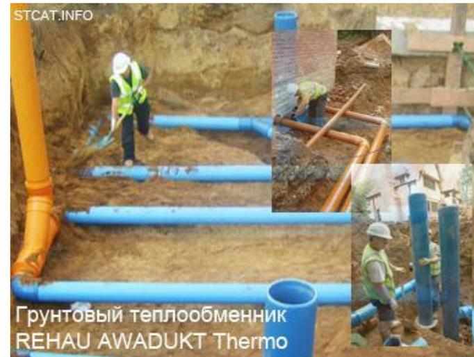
Грунтовые теплообменники (принцип отбора тепла от грунта посредством теплообмена)
