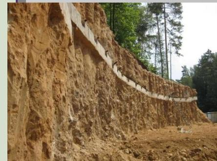
Анкеры могут устанавливаться во всех грунтах за исключением слабых (глины текучей консистенции, илы, заторфованные грунты и торфы, просадочные грунты, пески рыхлые). Скважины для установки анкера образуют путем бурения (с обсадными трубами, под глинистым раствором, шнеком) или забивкой или вдавливанием обсадной трубы.
