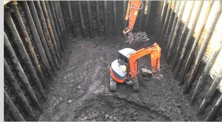
**Схема крепления котлована с помощью стальных труб**
