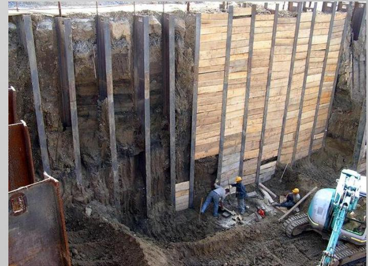
**Схема крепления котлована с помощью двутавровых балок**
