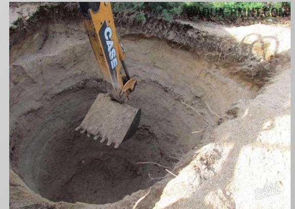
Выемки малой ширины с большой длиной называются **траншеями**, а небольших размеров в плане и имеющих большую глубину называются **шахтами**.
