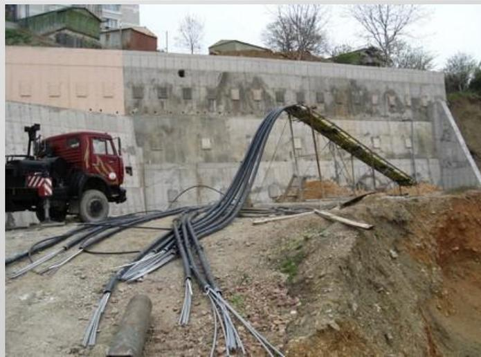
Применяются анкера различных типов и конструкций: гибкие 4 -х - 6 -ти прядевые буринъекционные анкера различной глубины с блокировочным натяжением 40 - 80 тонн, жесткие арматурные анкера длиной до 30 - 40 м и блокировочным натяжением 30 - 40 тонн.
