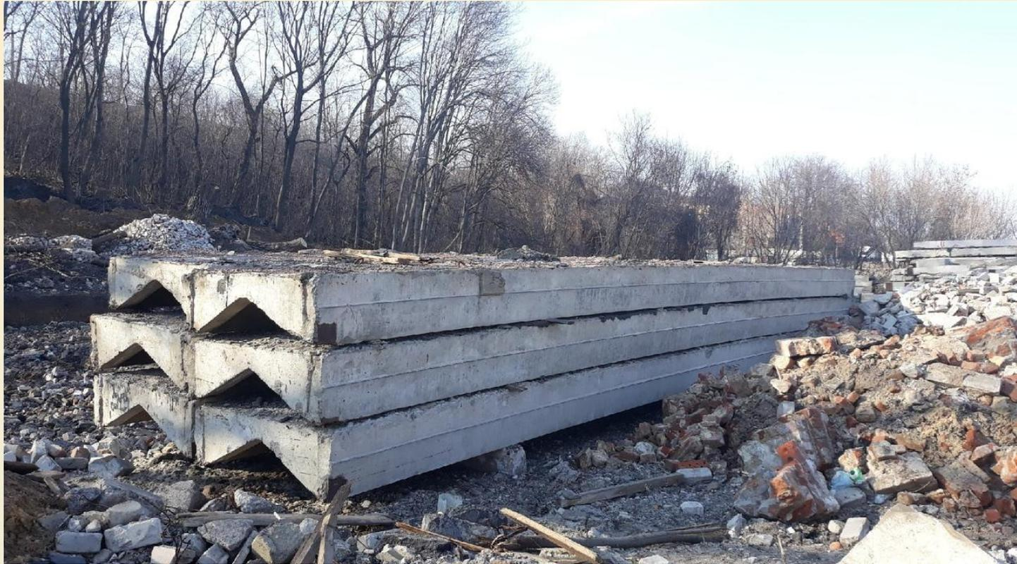
Фото 2. Б/у ж/б плиты, привезенные на строительство дома по адресу г. Воронеж, наб. М.Горького, 115. Класс бетона по прочности В90. Стоимость плиты  $12*1.5*0.45$ м с доставкой 4500р. 1 м<sup>2</sup> плиты стоит  $4500/18=250$ р при стоимости 1 м<sup>2</sup> ж/б плит 2000р. Разница в стоимости в 8 раз
