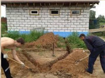
**Заземление** – преднамеренное электрическое соединение части электроустановки с заземляющим устройством.
