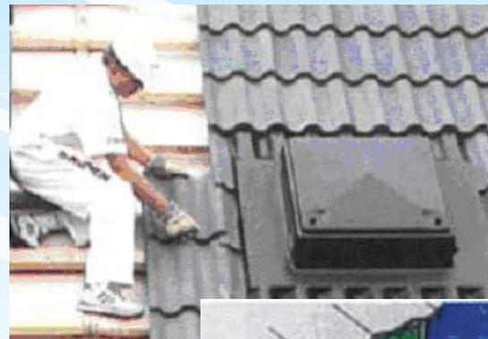
Примыкание черепицы к вентиляционному люку
