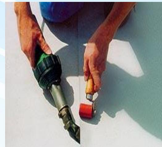
Укладка ПВХ мембран АЛЬКОРПЛАН при помощи специального сварочного оборудования и фена (слева на право).
