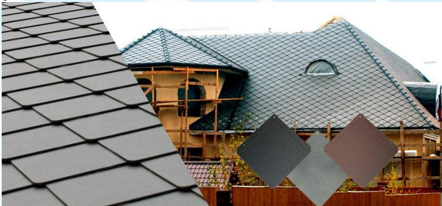
Плитки крепятся к обрешетке довольно оригинальным способом: у них есть отформованное на производстве монтажное отверстие, похожее на замочную скважину. Они просто вешаются на саморез, прибитый к шаговой обрешетке. Это позволяет соседним плиткам перемещаться относительно друг друга по принципу рыбьей чешуи, избавляя монтажников от лишних работ по подрезке. При таком методе укладки компенсируются возможные деформации при усадке здания.
