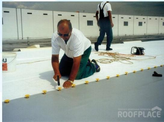
**Механически закрепляемая система.** Надежно фиксируется кровельная мембрана к основанию крыши полимерными тарельчатыми винтовыми дюбелями, которые затем герметизируются. Такой способ в основном применим при необходимости жесткой и надежной фиксации, а именно на скатных крышах.
