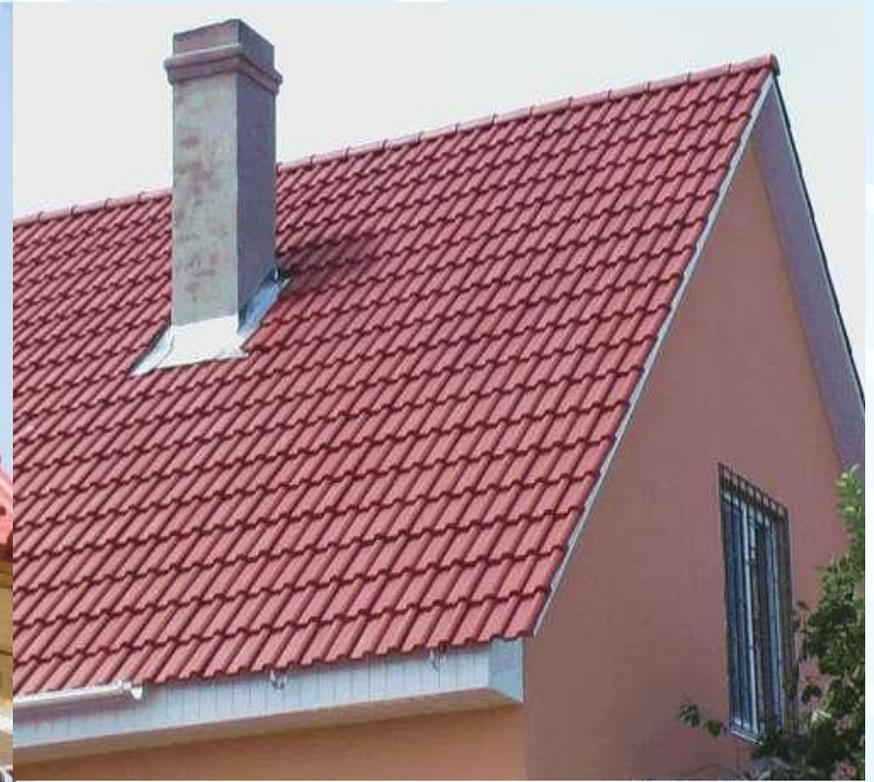
Полимерно-песчаная черепица изготавливается из композитного материала, в котором цемент, как связующий компонент, заменен на более прочный полимер. Такая черепица обладает всеми свойствами натуральной.
