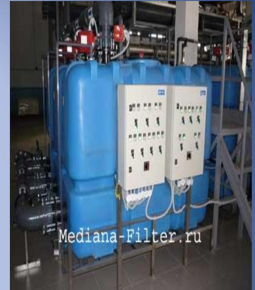
**Озонирование** - при этом процессе возможно одновременное окисление примесей, обесцвечивание, дезодорация, обеззараживание сточной воды и насыщение ее кислородом. Преимуществом этого метода является отсутствие химических реагентов при очистке сточных вод.
